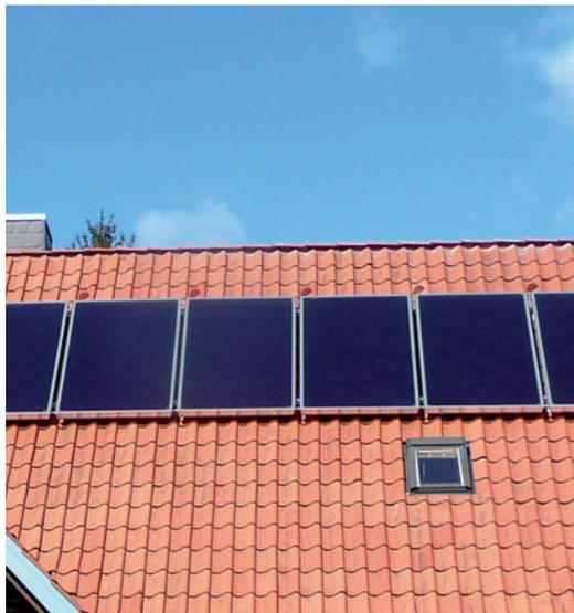
Die Aufdach-Montage eine einfache und günstige Variante wenn ein Haus mit einer Solaranlage nachgerüstet werden soll oder ein Neubau erstmals ausgestattet wird. Hierbei werden die Solarkollektoren so montiert, dass die gesamte Dacheindeckung erhalten bleibt.
