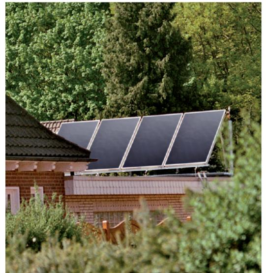
Natürlich ist es auch möglich, die Solarkollektoren von COSMO auf einem Flachdach oder auf eine Garage zu montieren. Allerdings müssen die Kollektoren dort grundsätzlich schräg gestellt werden (25 - 45°), um die größtmögliche Ausbeute der Sonnenenergie zu garantieren.
